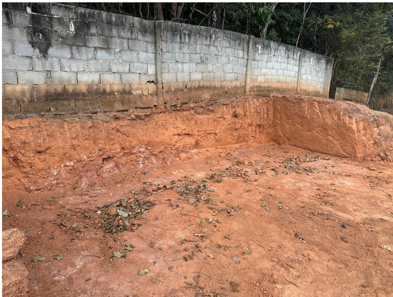
Foto 02 – Detalhe da localização do terreno para execução das obras da base.
